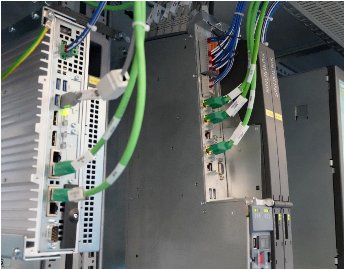
図 3：制御盤に設置された PLC（右）と IPC（左）（緑色のケーブルは PROFINET 用） 出所）スターラグ社撮影。
