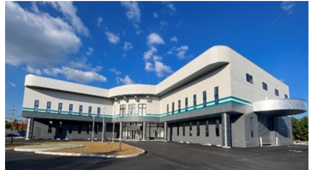
写真4 管路防災研究所 全景
