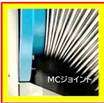
写真3 変位時に大小の山が折り畳む
