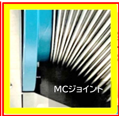
写真3 変位時に大小の山が折り畳む
